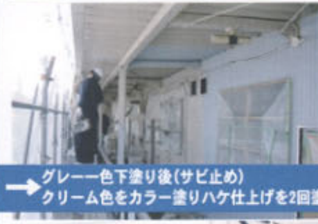
塗装前 → 下地調整樹脂 モルタル工事一式
